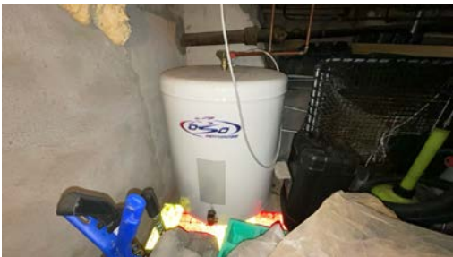
Varmtvannstank.
