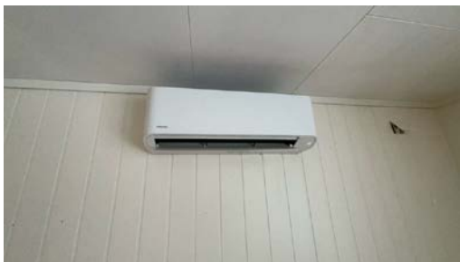
Varmepumpe.
