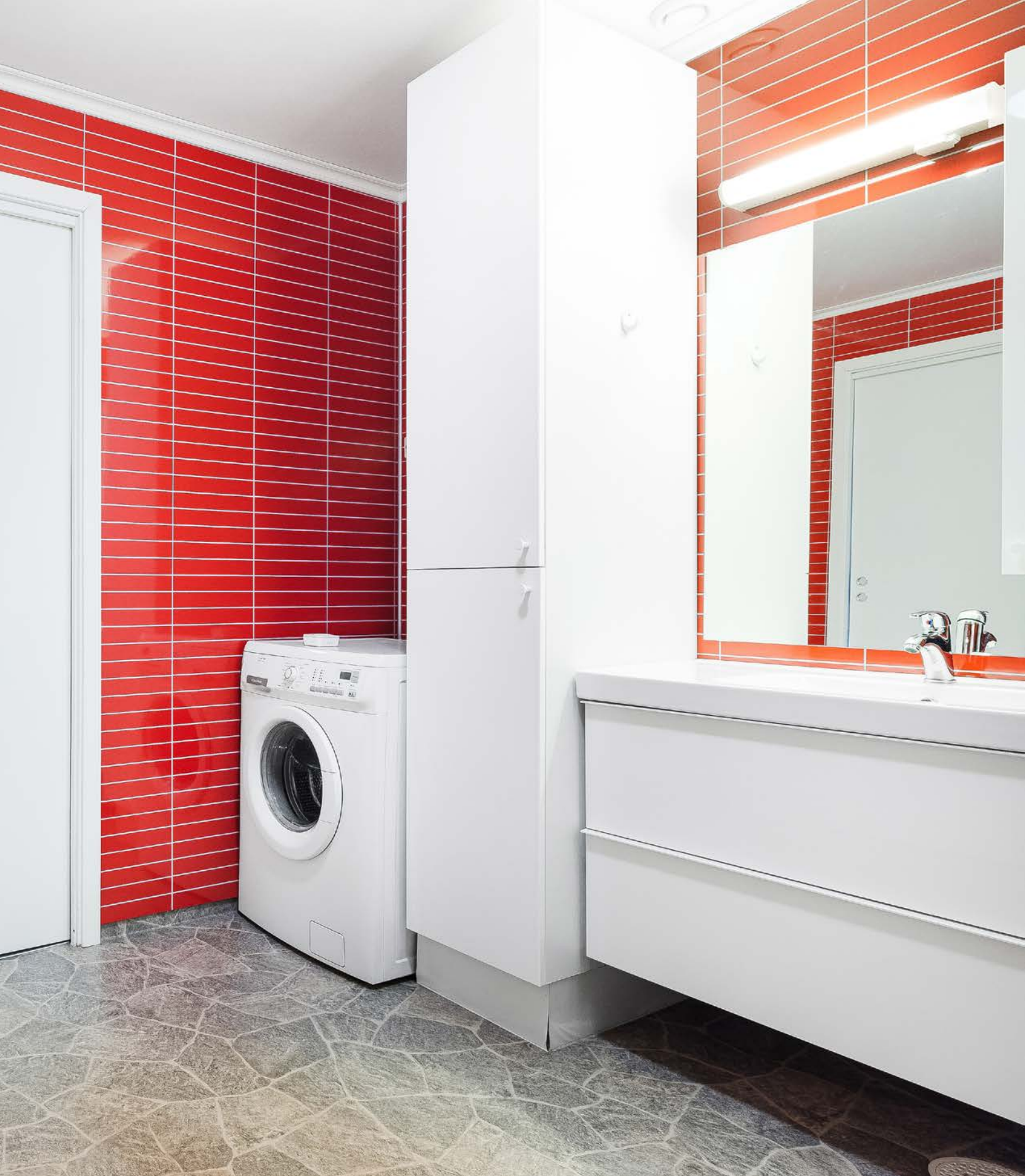
Bad/vaskerom inneholder dusjnisen, vegghengt toalett, servant i innredning, skap og vannuttak for vaskemaskin. Belegg på gulv og våtromsplater på vegg
