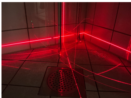
Fall på baderomsgulv er kontrollert med krysslaser.
