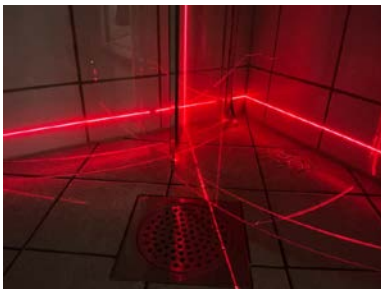
Fall på baderomsgulv er kontrollert med krysslaser.
