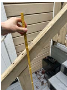
Topp håndløper målt til underkant av 80cm
