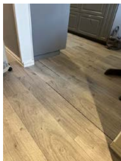
Sprekk i laminatgulv ved kjøkken
