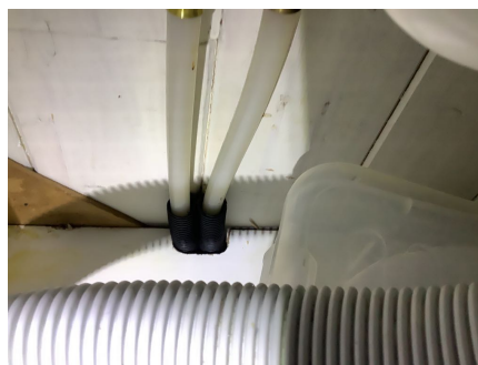
Det mangler tettemuffer i enden av varerør i benkeskap på kjøkken.
