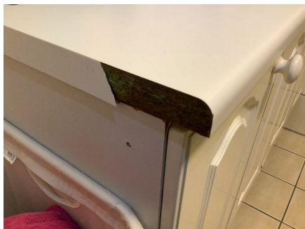
Skadet kantlist på servantinnredning.
