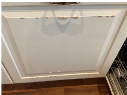
Eksempel på svellskadet front.
