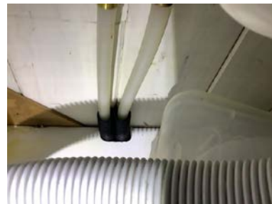
Det mangler tettemuffer i enden av varerør i benkeskap på kjøkken.
