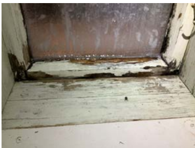
Trevindu med innvendig fuktbelastning som følge av kondens.
