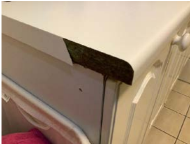
Skadet kantlist på servantinnredning.
