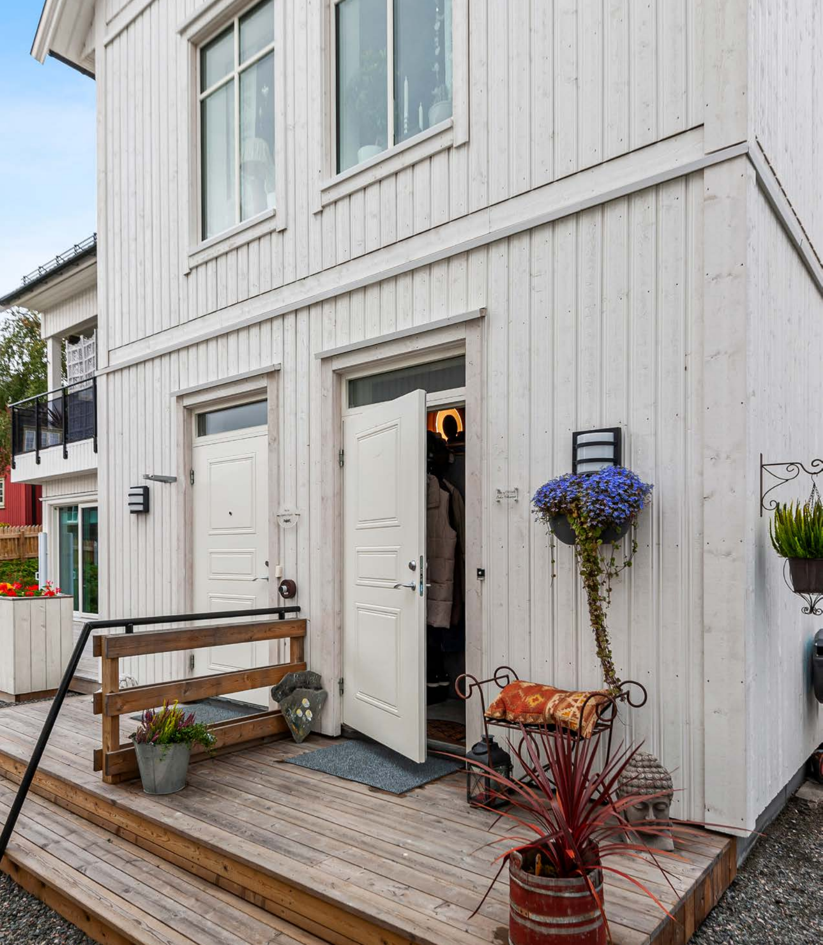
Inngangsparti med terrasse
