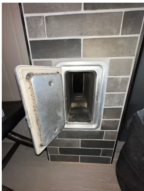
Viser sotluke innvendig.
