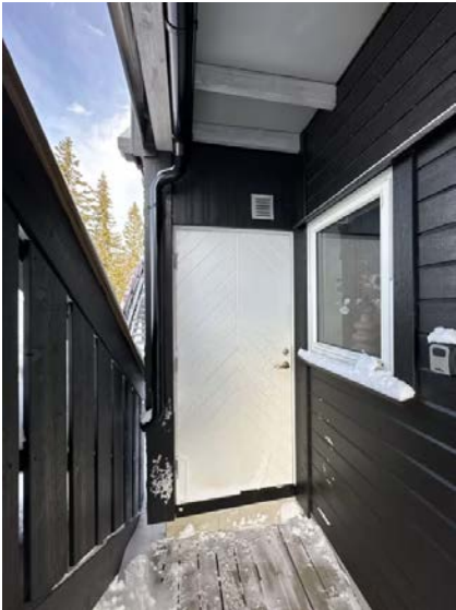
Viser bod med utvendig adkomst.
