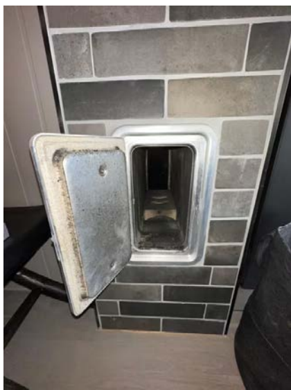
Viser sotluke innvendig.
