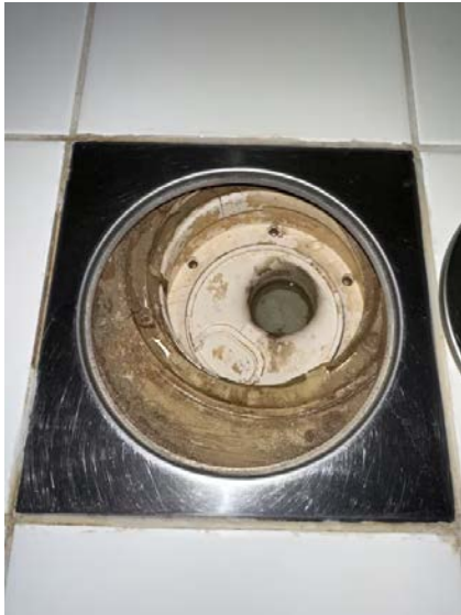
Viser sluk i dusjsonen.
