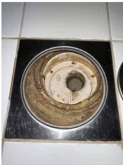
Viser sluk i dusjsjonen.
