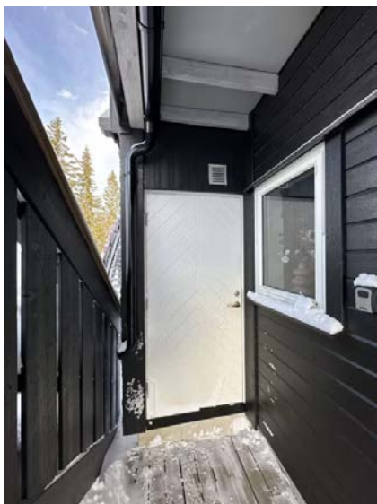
Viser bod med utvendig adkomst.
