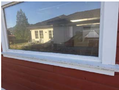
Værslitt overflate vindu.
