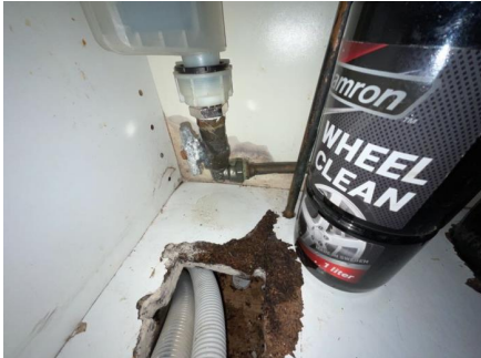
Lekkasje fra rør i kjøkkenbenk.
