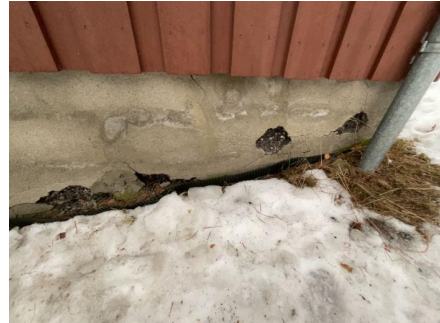
Oppsmuldring fra utvendig side av grunnmur.
