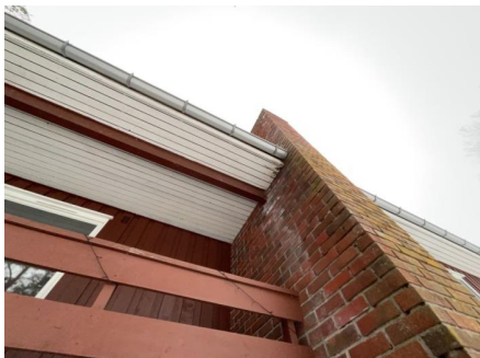
Fuktskader i spaltepanel (gesimskasse) som støter inn mot pipa.
