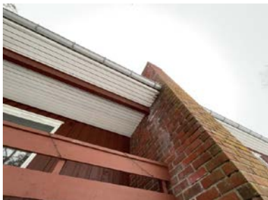
Fuktskader i spaltepanel (gesimskasse) som støtter inn mot pipa.
