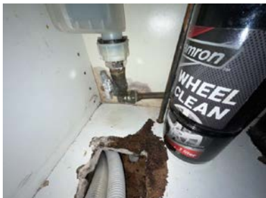
Lekkasje fra rør i kjøkkenbenk.
