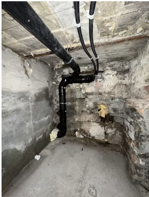
Viser avløpsrør i kjeller.
