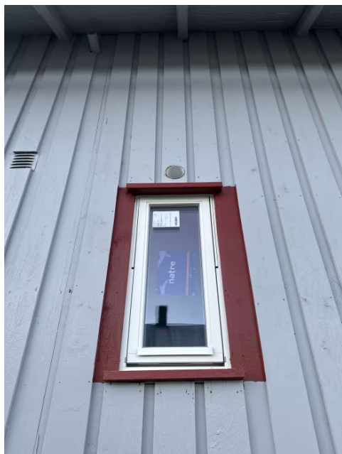
Ventil mangler utvendig på avtrekk.
