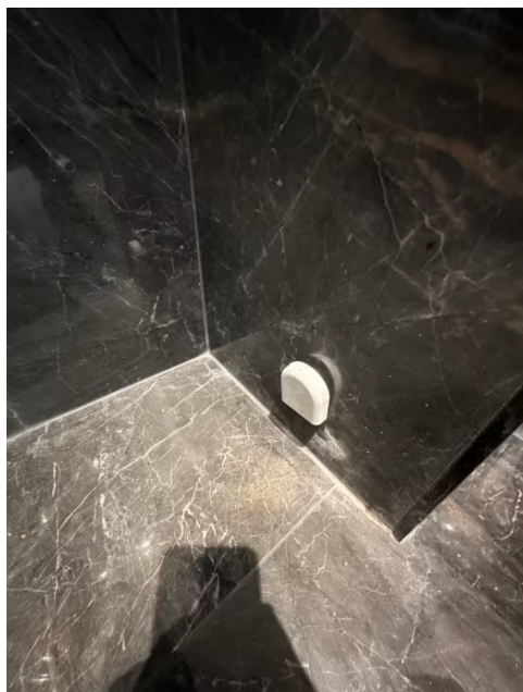
Viser avrenning fra fordelerskap.
