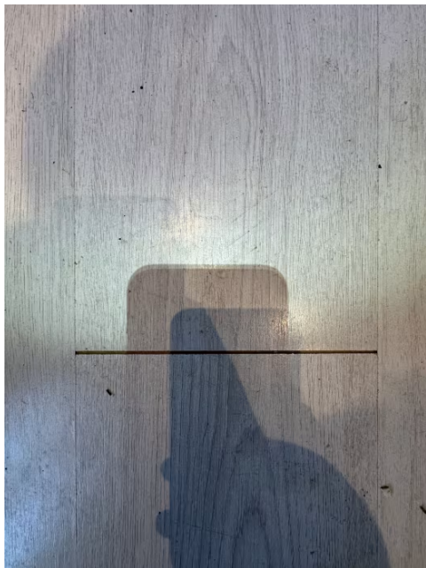
Viser eksempel på sprekker i skjøter ved gulv.
