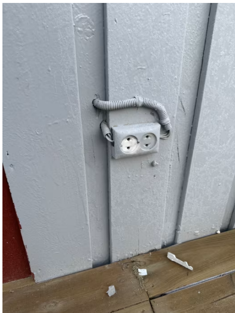
Viser ujordet stikkontakt utvendig som ikke beregnet for utvendig montering. Kabler er avslutet ufagmessig.
