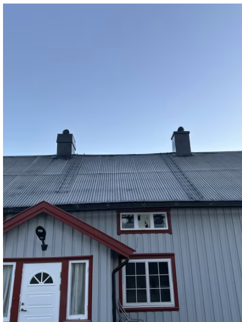
Viser del av taktekingen.
