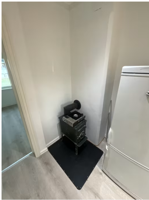
Viser vedovn på kjøkken.
