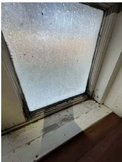
Det registreres råteskader i karmen på de eldste vinduer med enkle glass.
