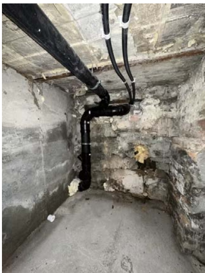
Viser avløpsrør i kjeller.
