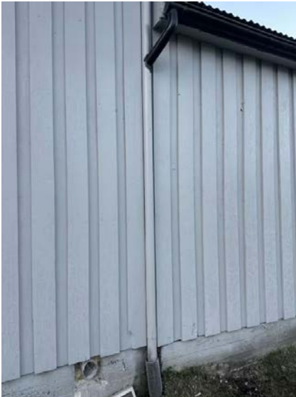
Deler av nedløpsrør er ført videre til nedgravd drenerør.
