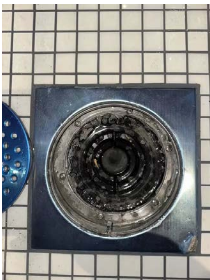
Viser sluk i dusjsonen.
