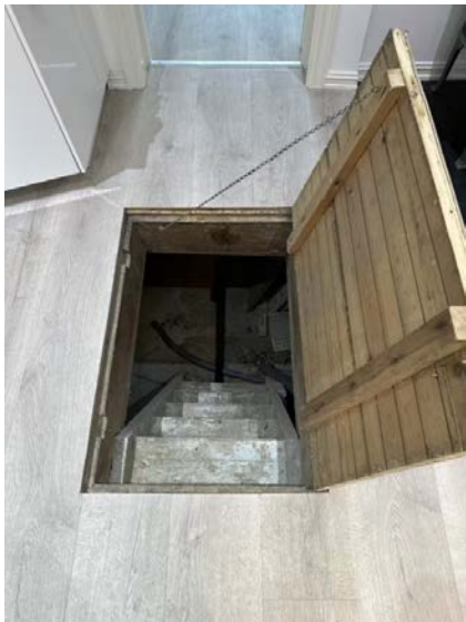
Adkomst til grovkjeller via luke på kjøkken.
