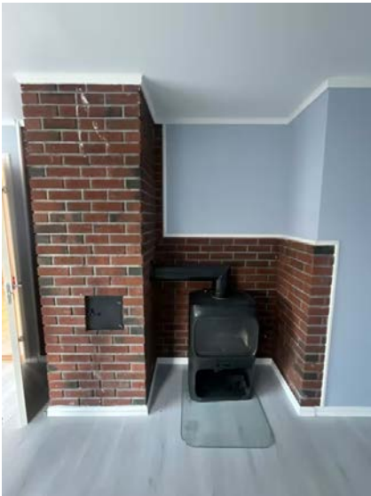
Viser vedovn og sotluke i spisestue.
