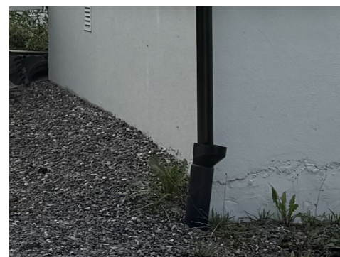
Ingen påvist fukt- grunnmursplast
