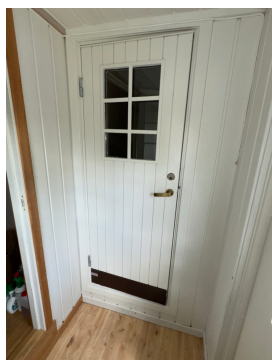
Det er montert ytterdør med glassfelt til bad.
