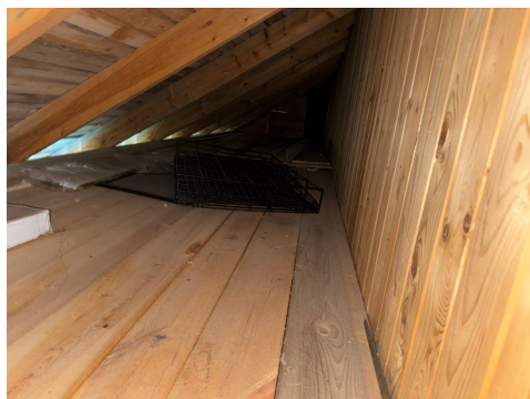
Inspeksjonskott bak knevegger.
