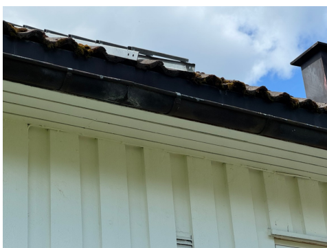
Stedvis tegn til lekkasjer på takrenneskjøter
