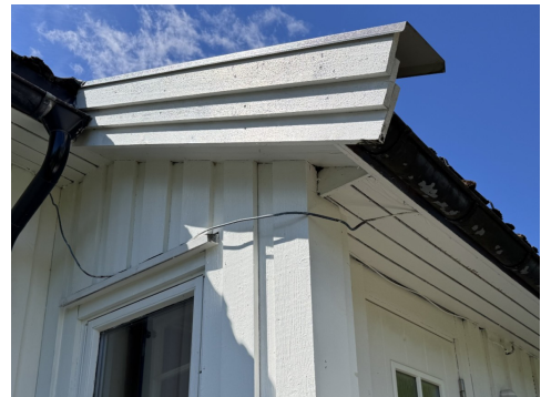
Løse kabler med ukjent funksjon
