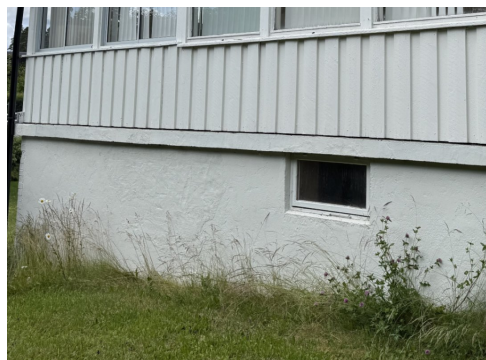
Ingen påvist fukt- grunnmurs
