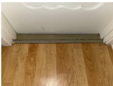
Liten/tett tilluftspalte under dør.
