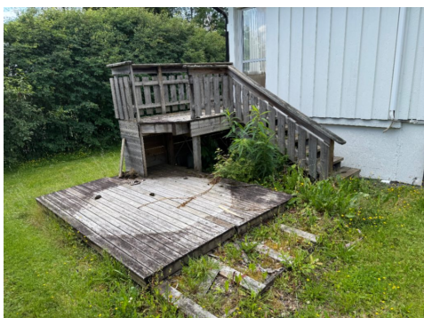
Manglende rekkverk.
