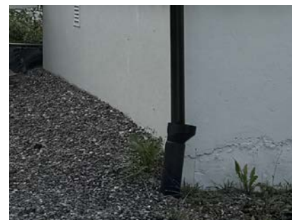
Ingen påvist fukt- grunnmursplast
