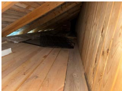
Inspeksjonskott bak knevegger.
