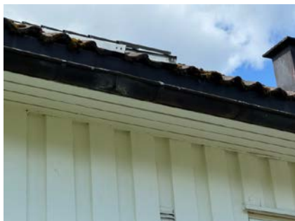
Stedvis tegn til lekkasjer på takrenneskjøter
