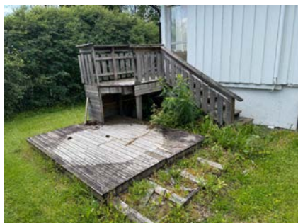
Manglende rekkverk.
