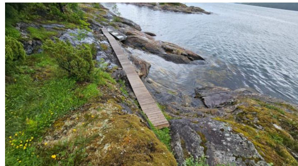
Gangbro mot båtplass.
