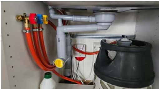
Kontroll av benkeskap.
