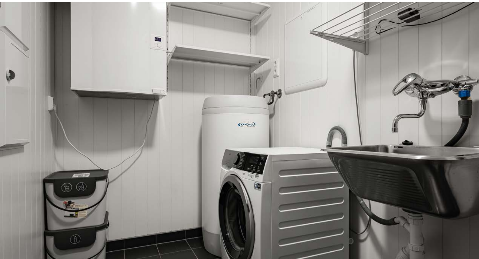
Leiligheten har også en innvendig bod/teknisk rom med utslagskum og opplegg for vaskemaskin. Rommet har mørke fliser på gulv med gulvvarme og mekanisk avtrekk.
