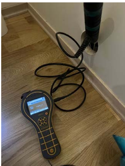
Undersøkelsen viser ingen tegn til fukt i konstruksjonen.
