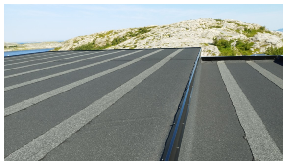
Kontroll av tekkingen.
