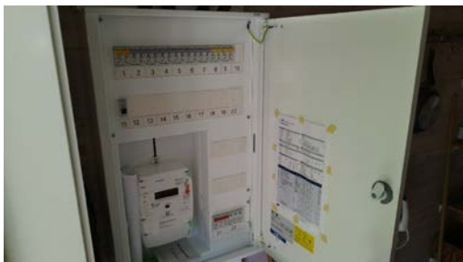
Kontroll av sikringsskapet.
