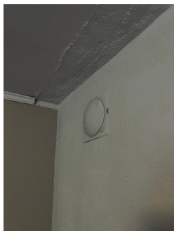
Avtreksventil i soverom i kjeller
