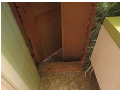
Laget hull i vegg mot bod fra våtrommet.
