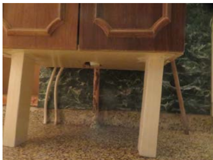
Skader på innredning.
