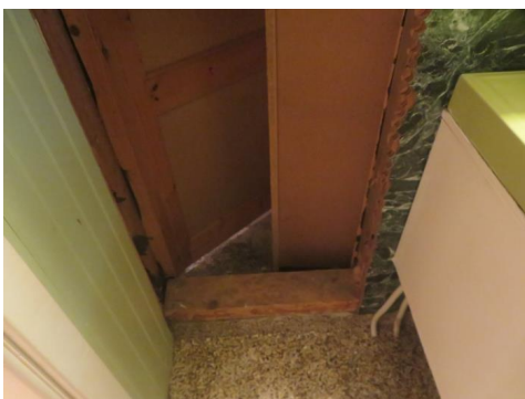
Laget hull i vegg mot bod fra våtrommet.
