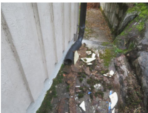
Taknedløp på baksiden av huset.
