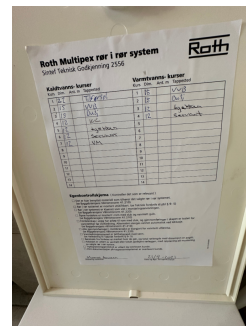
Kursoversikt for rør i samleskap
