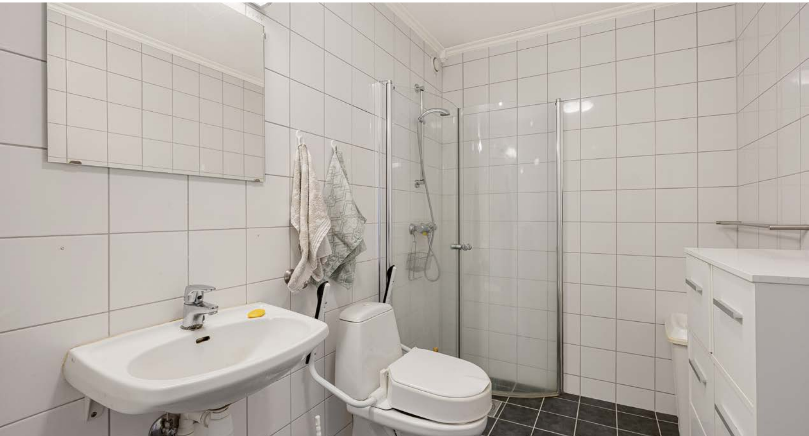
Badet er utstyrt med en vegghengt servant, gulvmontert toalett, dusjhjørne med innfellbare glassdører og veggmontert hånddusj.
