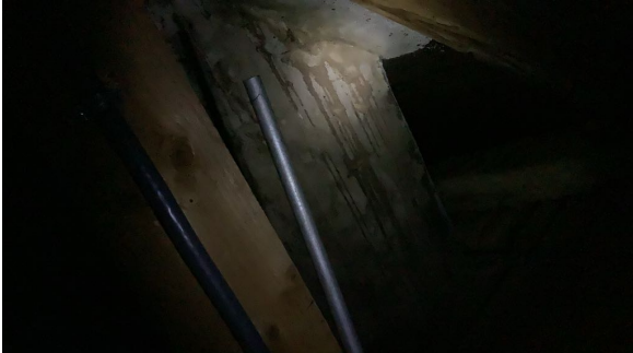
Det er rennemerker/kondens på pipe.
