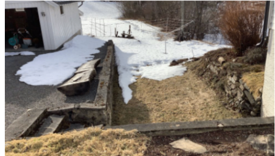
Støttemur i terreng.
