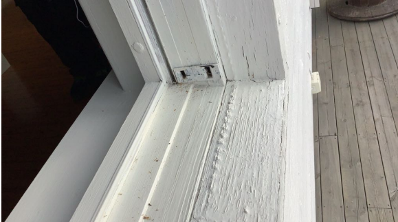
Vannbrett er plassert eil på vinduer. Vann kan renne inn i vegg.
