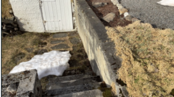
Støttemur for inngang til kjeller.
