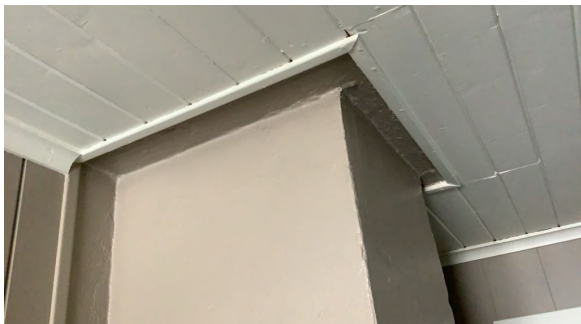
Teglpipe, bilde fra loftetasjen.
