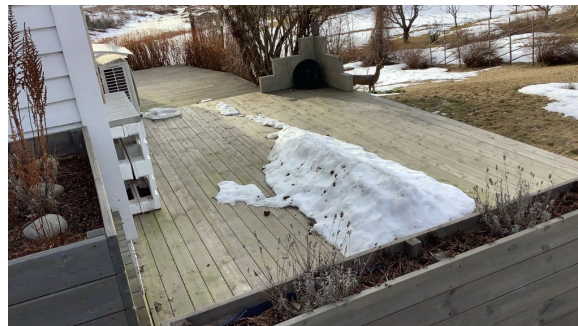
Terrasseplattung mot nord.
