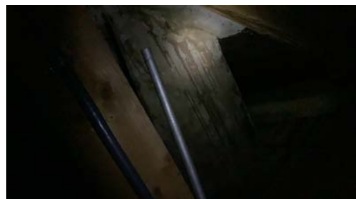
Det er rennemerker/kondens på pipe.
