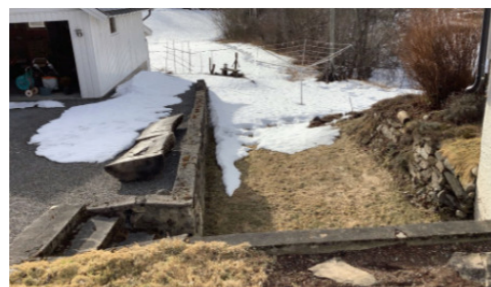
Støttemur i terreng.
