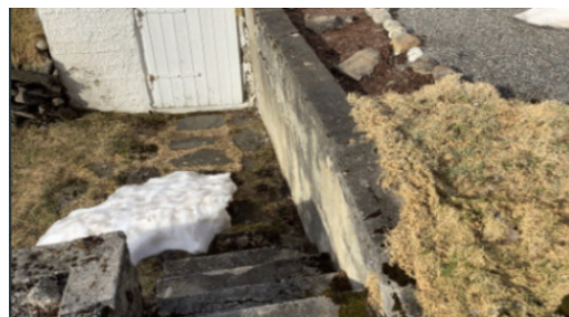
Støttemur for inngang til kjeller.
