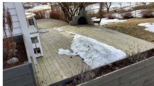
Terrasseplattning mot nord.
