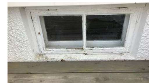
Eldre koblede vinduer i kjeller.
