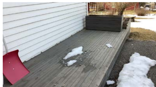
Terrasseplattning foran inngang.
