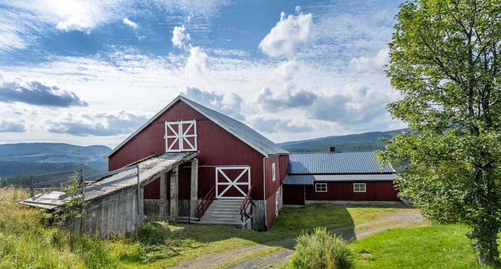
Fasade driftsbygning med låvebru
