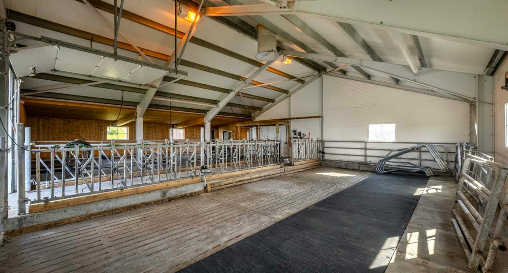
Fjøs med søylefri del (23 bås plasser med spaltegulv). Isolert leddheiseport.
