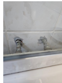
Røregjennomføringer i dusjsone.
