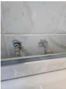
Røregjennomføringer i dusjsone.
