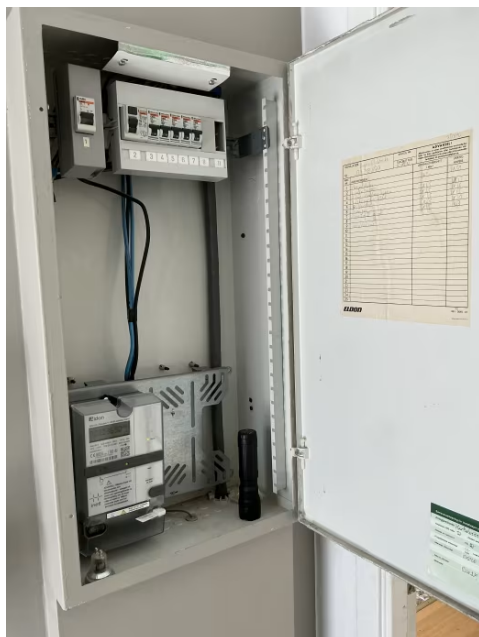
Sikringsskap står i entre/gang.
