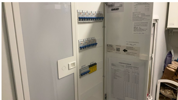
El-anlegg med automatsikringer. I hovedsak skjult ledningsnett. Sikringsskapet er plassert i teknisk rom.
