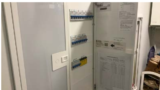
El-anlegg med automatsikringer. I hovedsak skjult ledningsnett. Sikringsskapet er plassert i teknisk rom.
