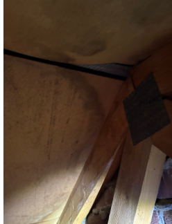
Fuktskjolder ved gjennomføring
