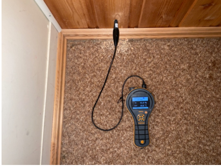
Måling av RH i hulrom viser akseptabelt nivå.
