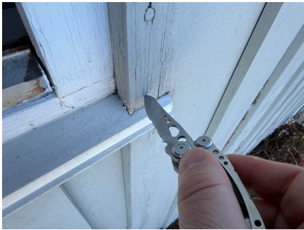
Belistning ned mot vannbrett
