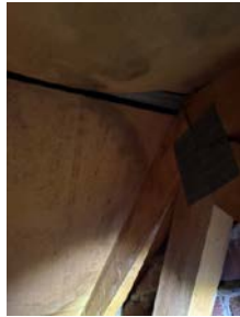
Fuktskjolder ved gjennomføring
