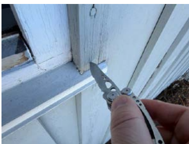
Belistning ned mot vannbrett
