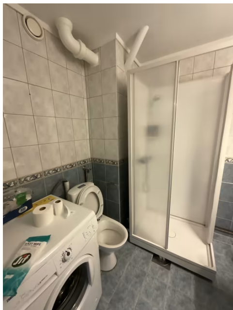
Viser gulvstående toalett og dusjkabinett.
