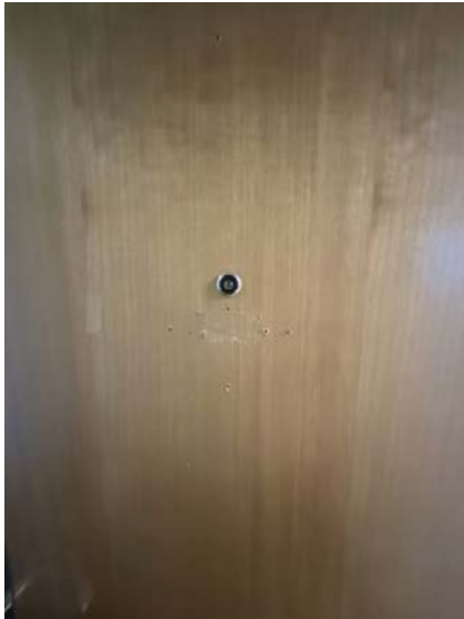
Viser merker på ytterdør etter dørskilt.
