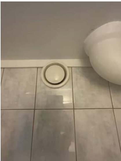
Viser avtrekk på bad.
