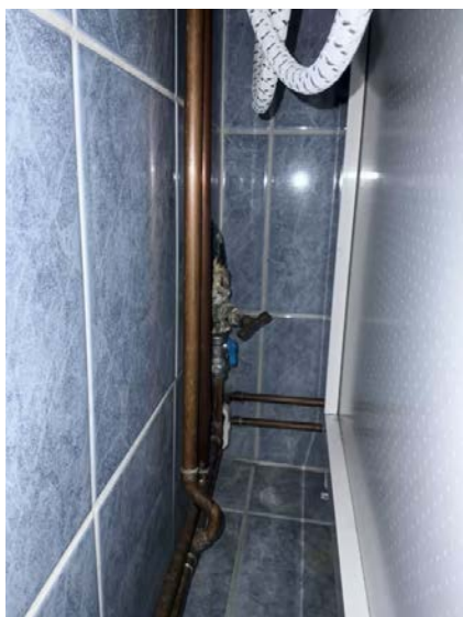
Viser eldre stoppekran plassert bak dusjkabinett på bad.
