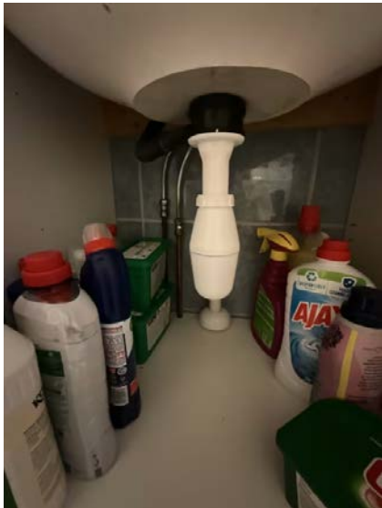
Vann - avløpsinstallasjoner under vask.
