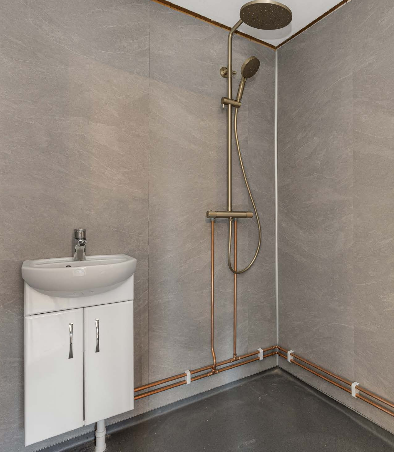
Badet i 2. etasje ble pusset opp i 2025, innredet med våtromsplater på veggene og våtromsbelegg på gulvet. Det er ikke varme i gulvet.
