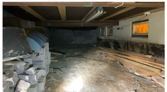
Bilde av krypkjeller.
