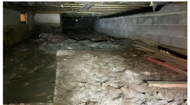
Bilde av krypkjeller.
