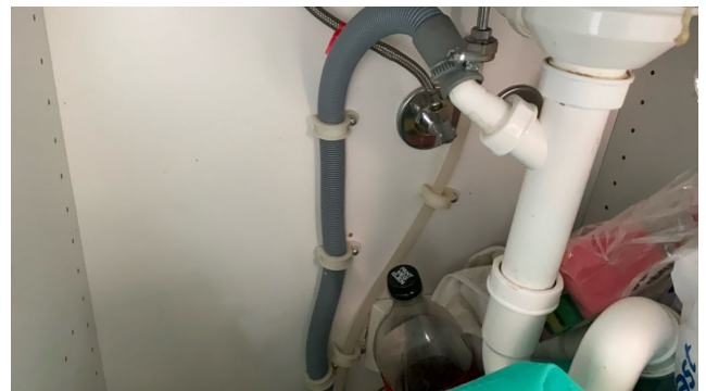
Synlige rør under kjøkkenbenken i hybelen.
