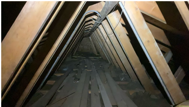
Adkomst til kaldtloft via luke med stige.
