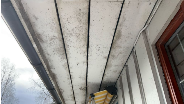
Luftespalte i gesims.
