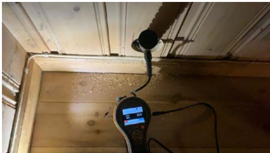
Bilde av fuktmåling med pigger i bunnsvill.
