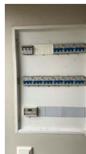
Sikringskap plassert på vegg i trapp ned til garasjen.
