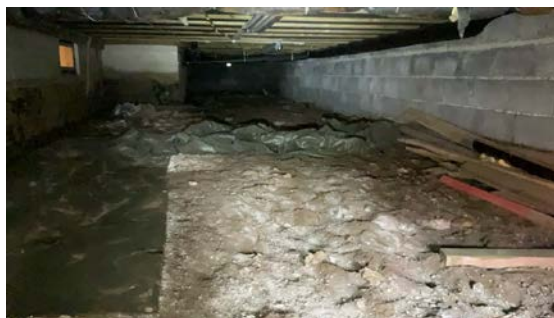
Bilde av krypkjeller.
