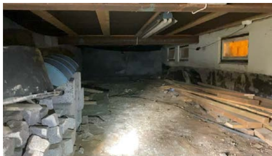
Bilde av krypkjeller.
