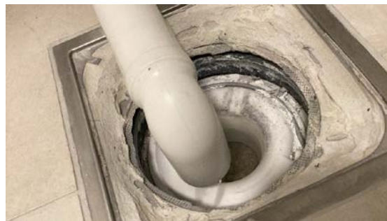
Viser sluk under vask på vaskerom.
