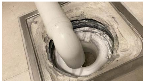
Viser sluk under vask på vaskerom.
