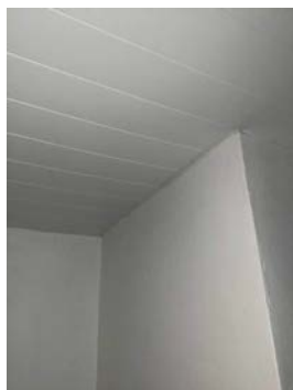
Panel ført helt inntil mursteinspipe.
