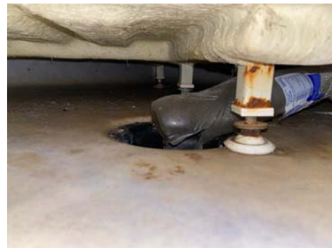
Sluk med ufagmessig utførelse på vannrør fra kabinett.
