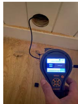
Fuktmåling uten unormale verdier.
