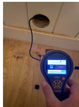
Fuktmåling uten unormale verdier.
