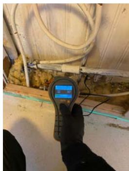
Fuktmåling gjort i åpent vegg på vaskerom uten unormale funn.
